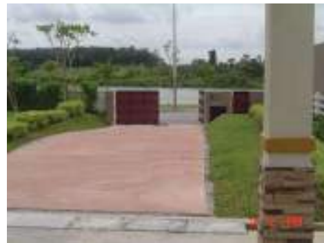
Concrete imprint empat segi tepat dan parking menggunakan terra cotta menggunakan kemasan broom finish
