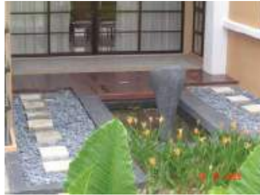
Kolam berserta bird rest dan concrete imprint kemasan dengan menggunakan pebble wash dan loose pebble
