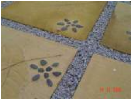
Concrete imprint berserta kemasan menggunakan batu aggregate.
