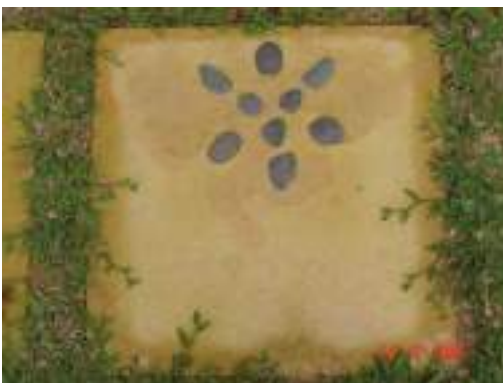
Concrete imprint kemasan dengan cow grass dan batu loose pebble
