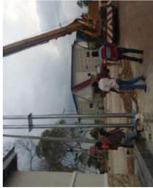
Membuat dan menaikkan tiang pintu gerbang untuk papan tanda
